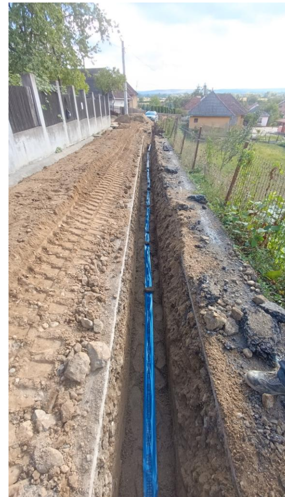
Pădurarului – pozare conductă
