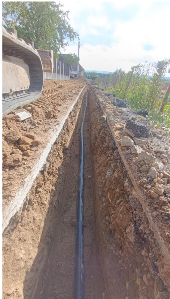
Pădurarului – conductă PEHD
